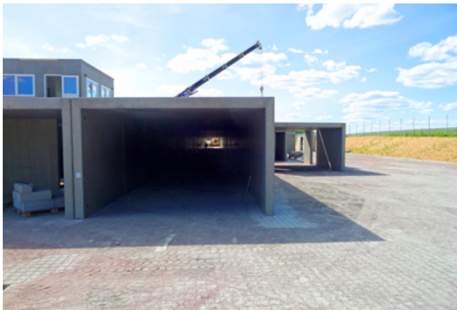
Bild från byggandet av Askersunds ÅVC
