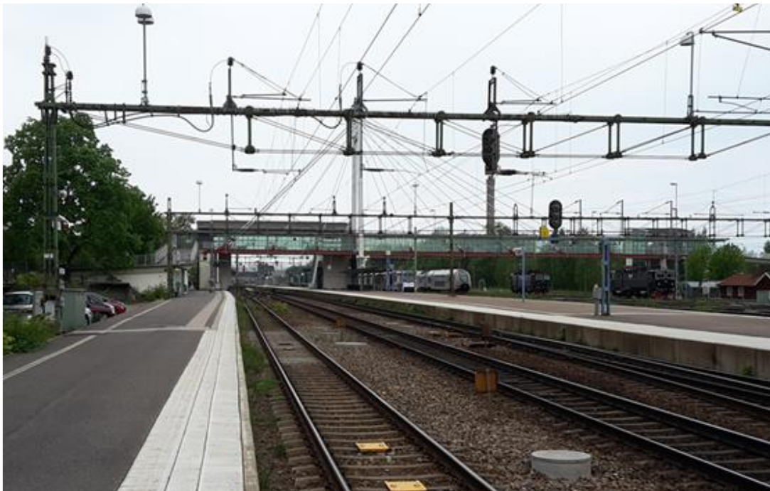
Figur 15: Spår 1 öster om stationshuset. Vy västerut.
