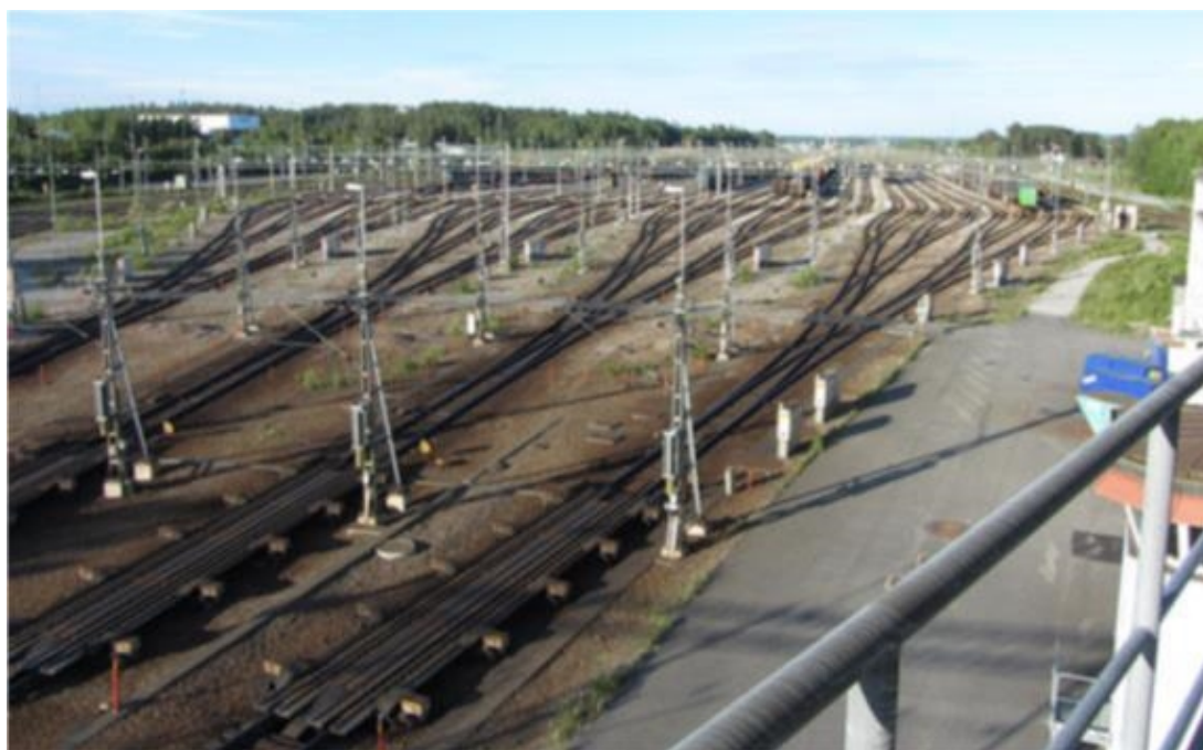
Figur 11: R-grupp med balkbromsar i förgrunden. Vy från rangertornet.
