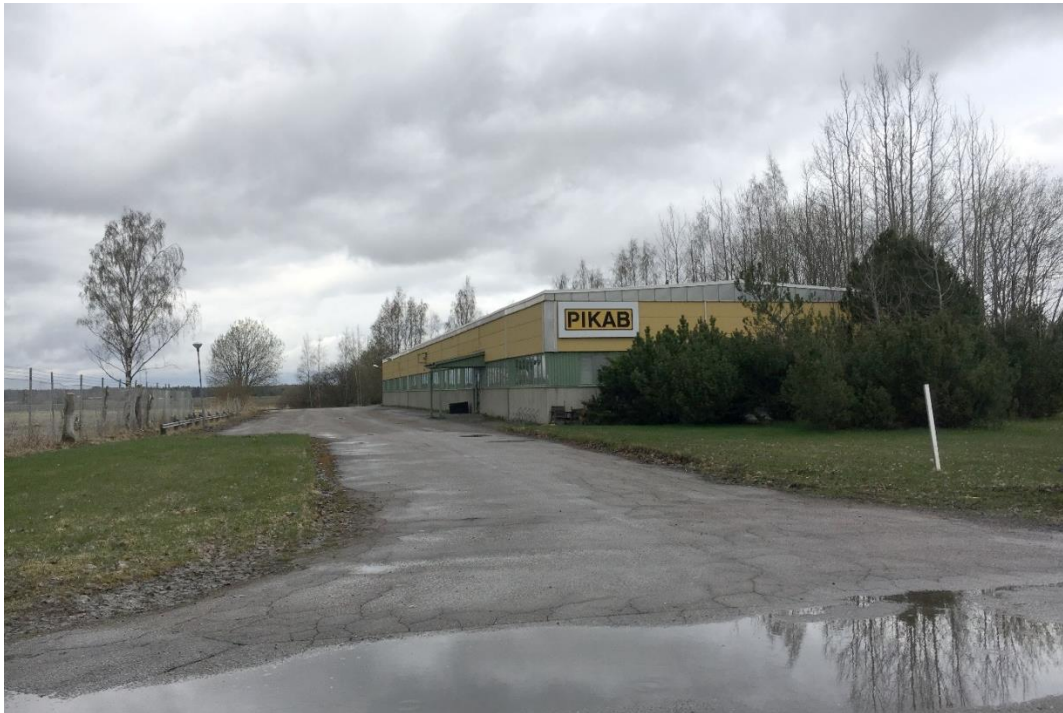
Befintlig industribyggnad på fastigheten.
