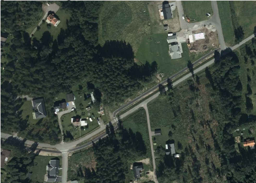
Gång- och cykelvägen mellan Rudolf gata och Elvas gata.
