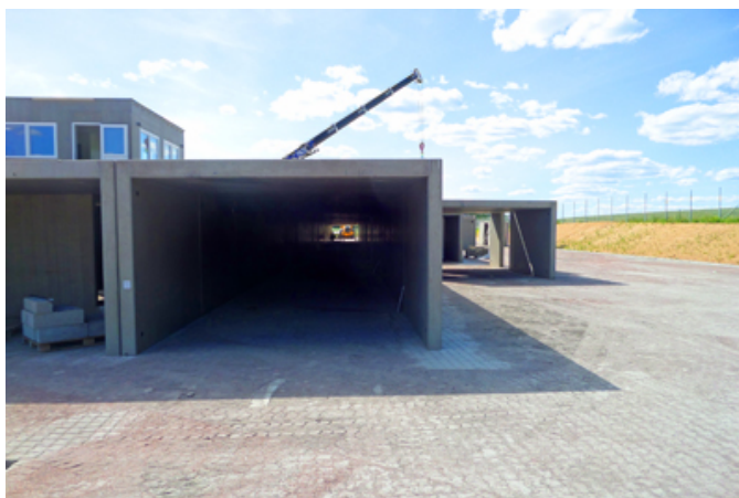
Bild från byggandet av Askersunds ÅVC
